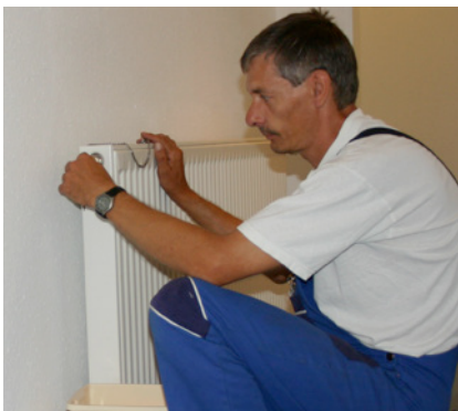
Foto: Ein Heizkörper wird entlüftet
