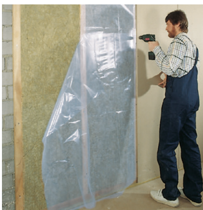
Ausführung der Innendämmung mit einer mattenförmigen Dämmung und Dampfbremse
